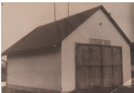
Před stavbou klubovny (archiv SDH Zbýšov)
