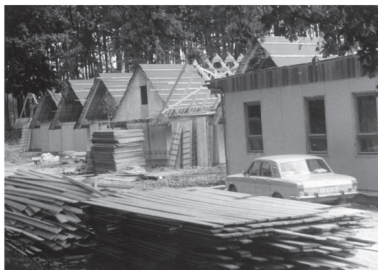
Fotografie z výstavby autokempu
